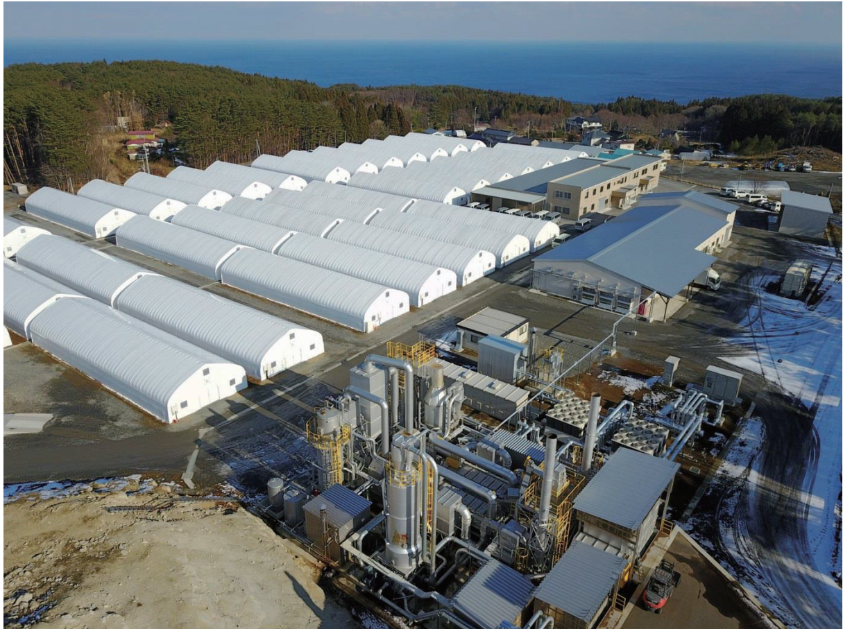
プラント全容。白い建屋は、本州一の生産量を誇る椎茸ハウス群
