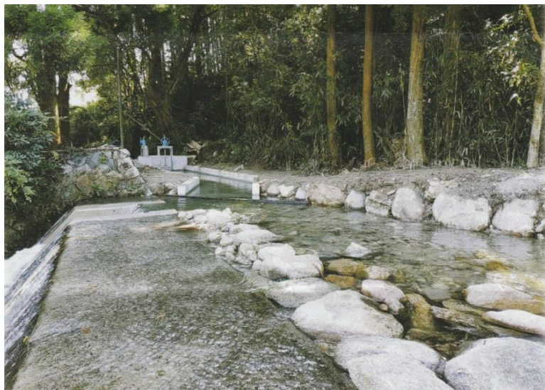
松隈小水力発電所（佐賀県吉野ヶ里町）
