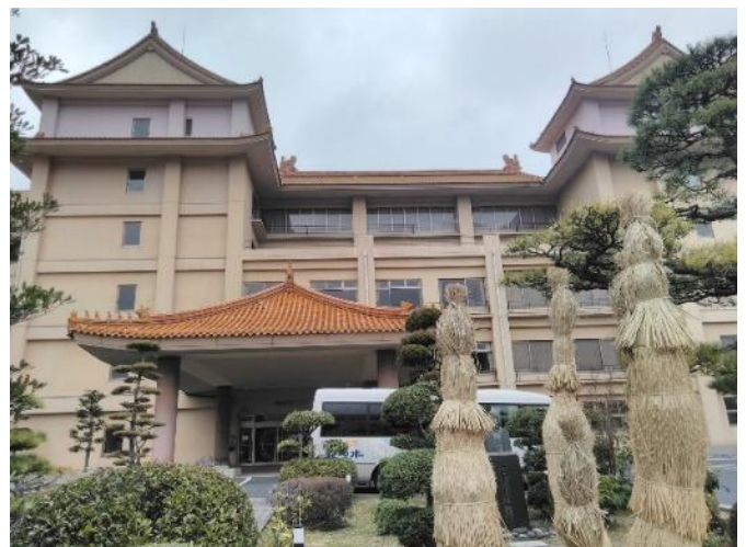
温泉熱を利用（ボイラー代替）する水明荘
