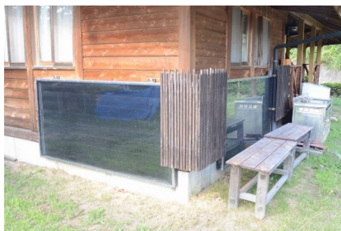
南西角の「ヒートウォール」は、 中古の太陽熱温水器の再利用
